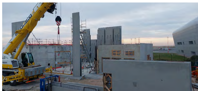
Illustration des travaux de la centrale d'échange thermique du réseau thermique du Grand Arénas
