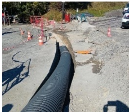
STATION D'AURON : Réfection d'un réseau d'eau pluvial - parking du Riou
