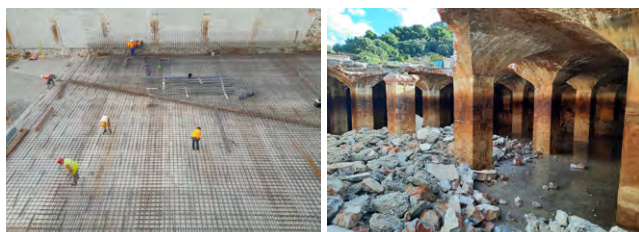
Démolition voûte et poteaux
