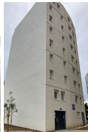
Réhabilitation bâtiment 37 et 8
