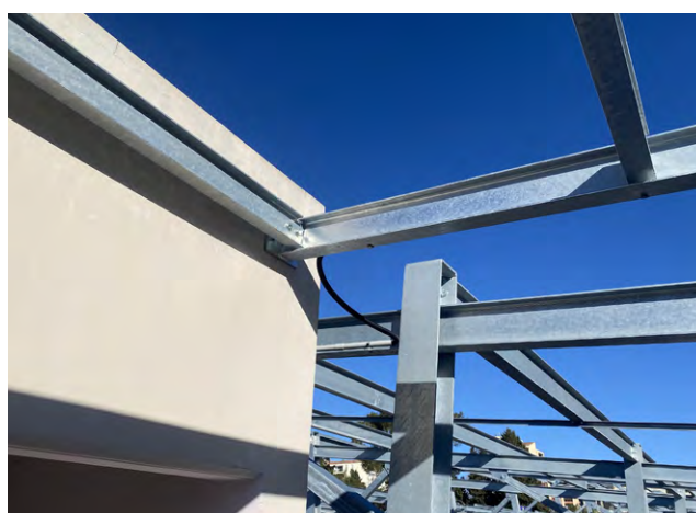
Travaux sur le parking Prévert à Carros.
