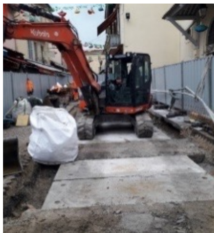
CAGNES-SUR-MER : Réhabilitation du réseau pluvial rue Jean Raymond Giacosa
