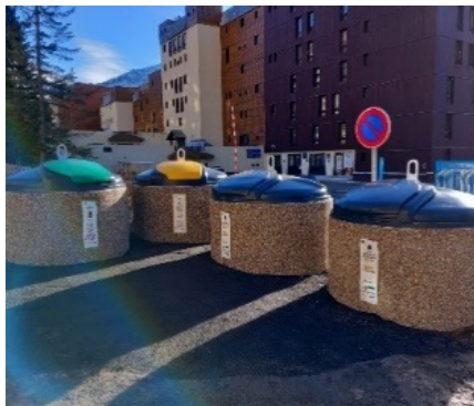
STATION D'ISOLA 2000 : Pose de conteneurs semi-enterrés
