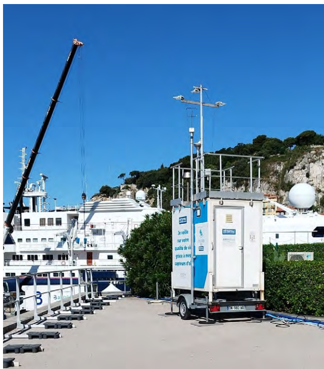
Station de mesure de la qualité de l'air AtmoSud sur le port de Nice
