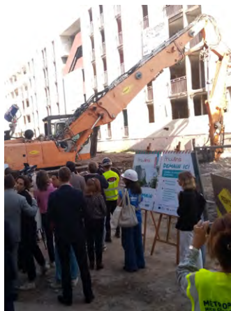
Démolition des bâtiments 6 et 8
