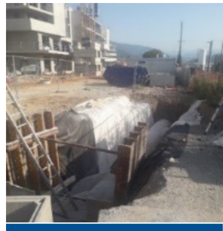
SAINT-LAURENT-DU-VAR : Dans le cadre du projet urbain partenarial des Pugets Nord, redimensionnement de la capacité du réseau des eaux pluviales du secteur
