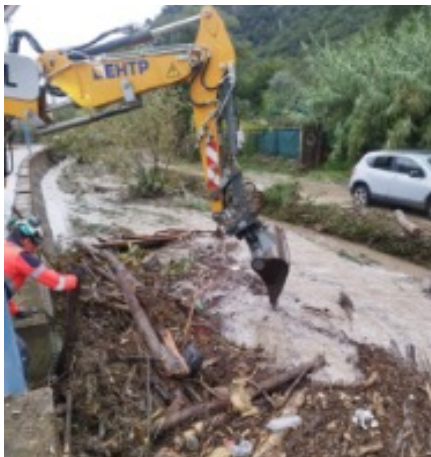
CARROS / LE BROC : Curage du canal pied de coteaux suite aux intempéries du 23 octobre 2024 (afflux de sédiments et de bois morts en provenance du vallon du Riou).
