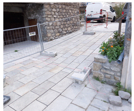
SAINT-DALMAS-LE-SELVAGE : Aménagement de la place centrale
