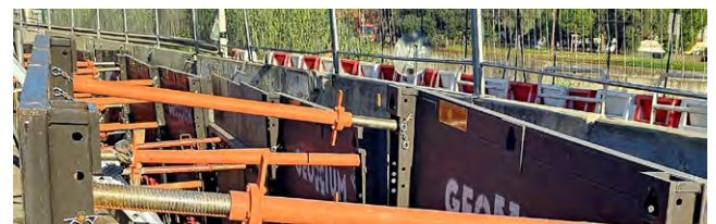
Montage des murs du hall d'expédition des matériaux
