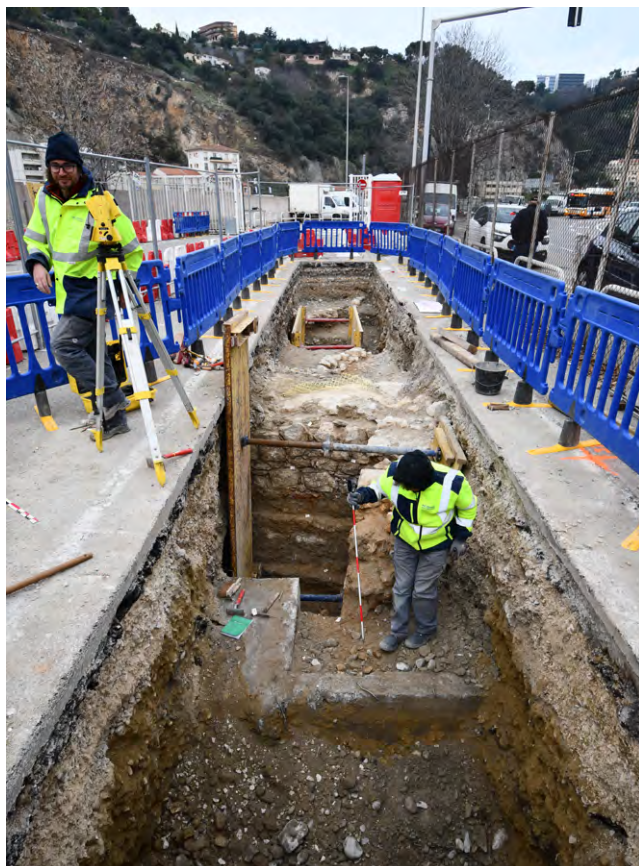
Tranchée de diagnostic de la ligne 5 du tramway (cl. SANCA)
