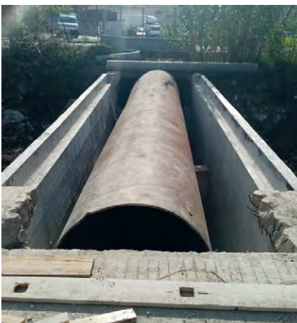
NICE : Curage et création d'un bassin de gestion sédimentaire suite aux inondations de 2022 à la Lavette
