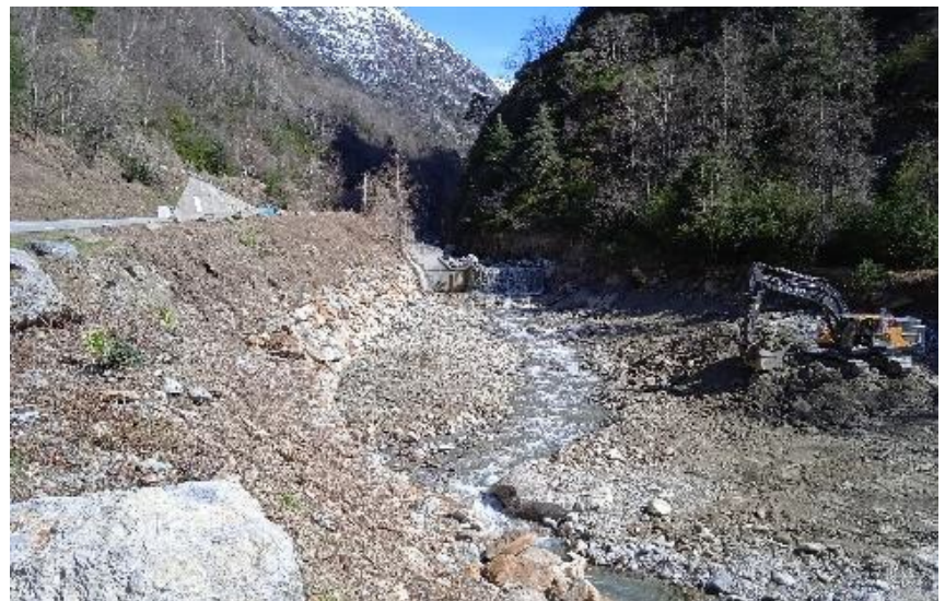
ISOLA : Opération de curage de la plage de dépôt de la Guerche (vallée de la Tinée).
