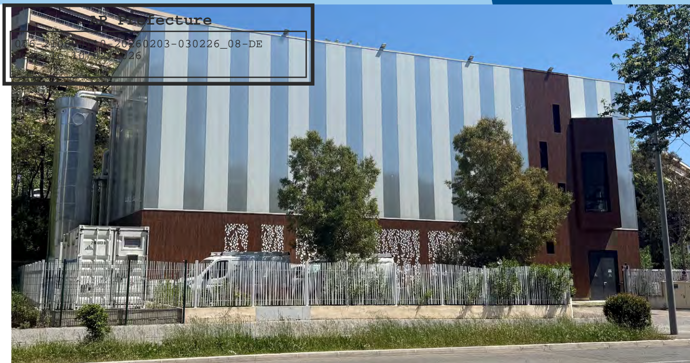
Illustration de la centrale Méridia Smart Énergie avec à gauche son stockage de chaleur en Inox et sa batterie électrique de quartier en container.
